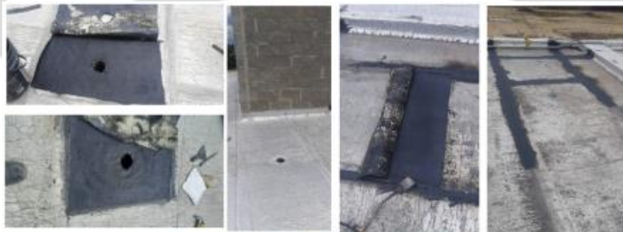
Mantenimiento Cubierta Dura
