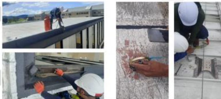
Mantenimiento Cubierta Metálica
