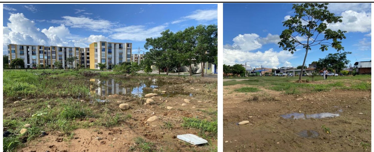
Zona baja del predio en el que se evidencia empozamiento de aguas pluviales.
