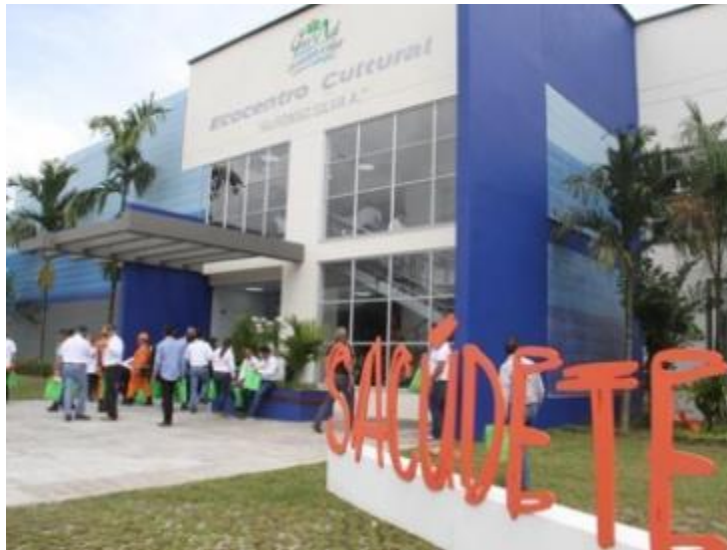
Figura 3-4 Centro Sacúdete construido en Guamal - Meta
