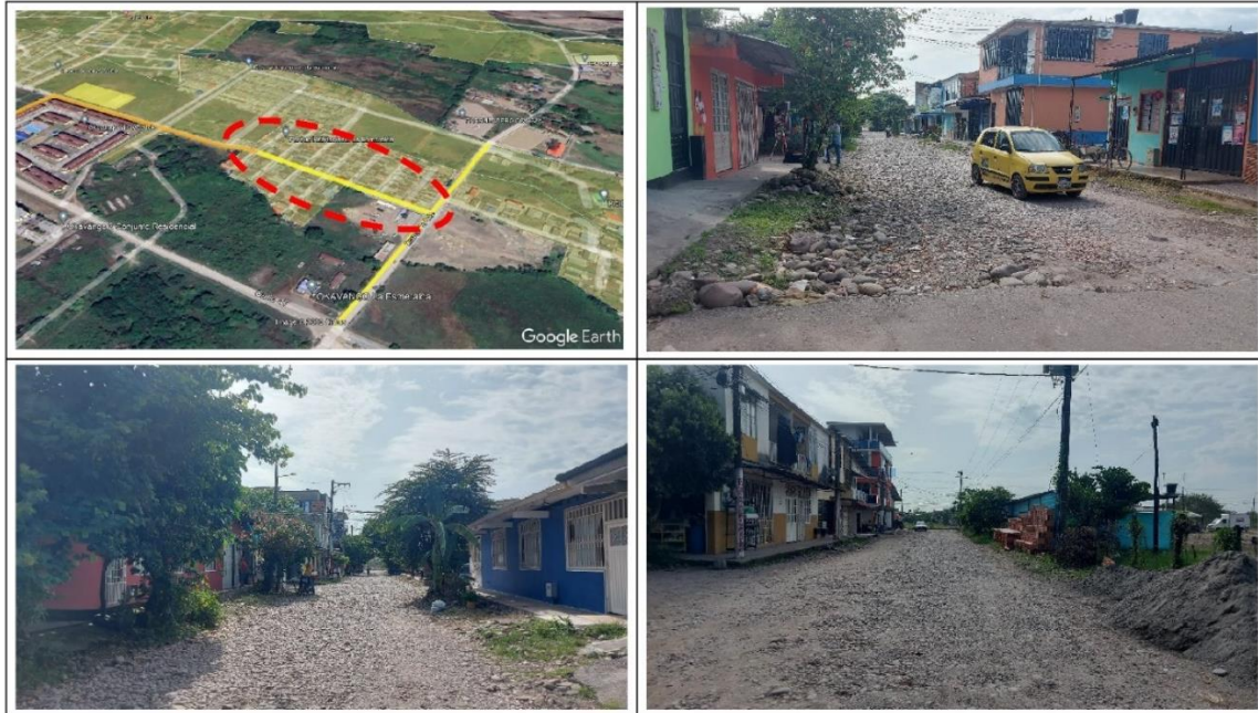
Ilustración 38. Registro fotográfico y localización de la vía principal girasol - calle 48 entre carrera 16 este y carrera 18 este (intervención # 2).
