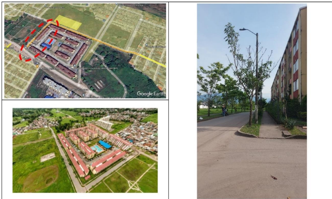
Ilustración 41. Registro fotográfico y localización de la zona de intervención del urbanismo TÁCTICO – B (intervención # 5).
