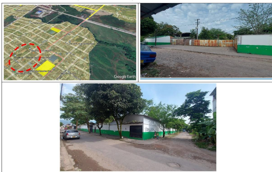
Ilustración 55. Registro fotográfico y localización de la Escuela Atanacio Girardot.
