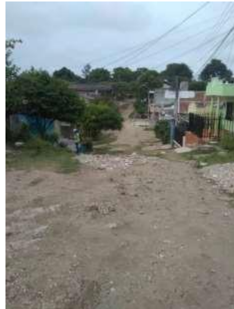
Ilustración 34. Fotografía del estado actual de la Calle 40A.
