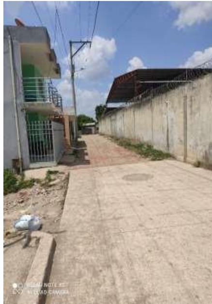
Ilustración 37. Fotografía del estado actual de la Calle 421. Fuente: Alcaldía de Sincelejo
