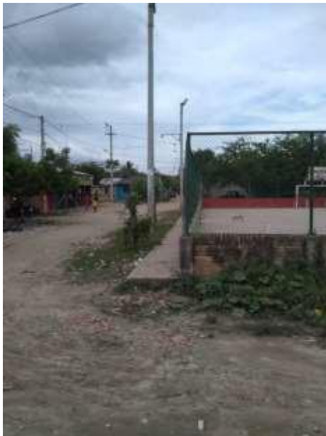
Ilustración 32. Fotografía del estado actual de la Calle 43B.
