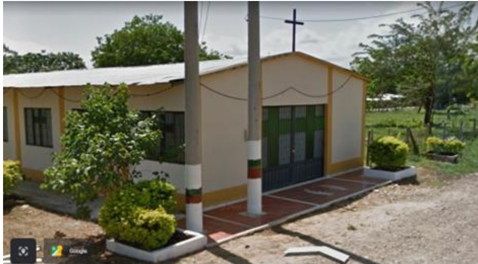
Ilustración 49. Iglesia ubicada en el área de intervención.
