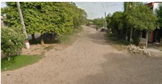
La cil 59 entre Carrera 8 Oeste cra 1ª Oeste
